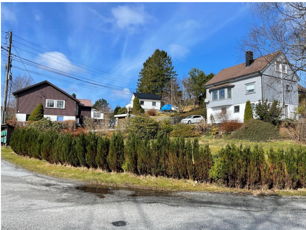
Figur 2-14 Fotografi av fasade syd, tatt fra veien Forvasshaugen. Foto: Norconsult.
