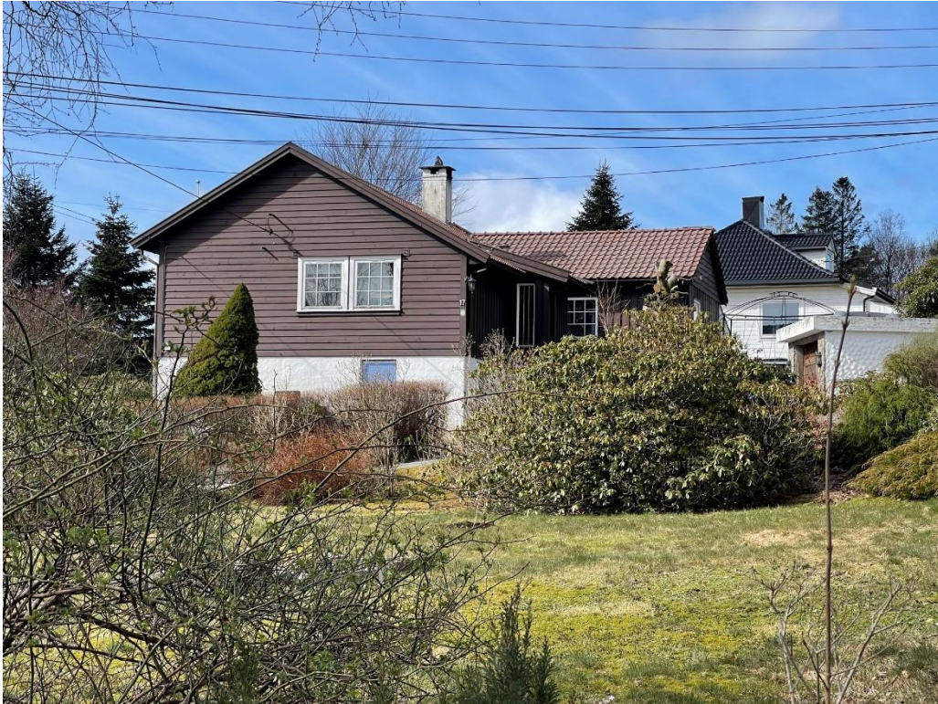
Figur 4-11 Fotografi av fasade øst. Foto: Norconsult.
