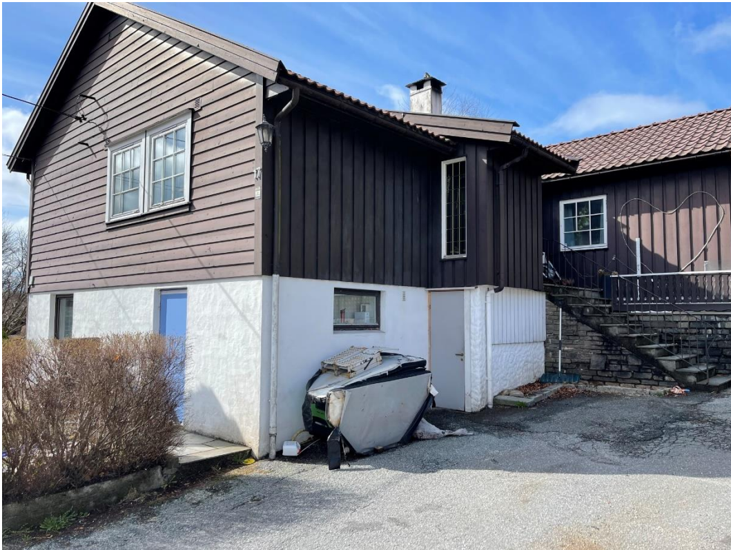
Figur 4-13 Fotografi av fasade nordøst. Foto: Norconsult.
