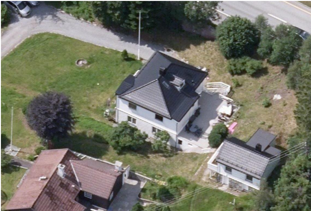
Figur 5-13 Skråfoto av fasade øst. Kilde: 1881.no
