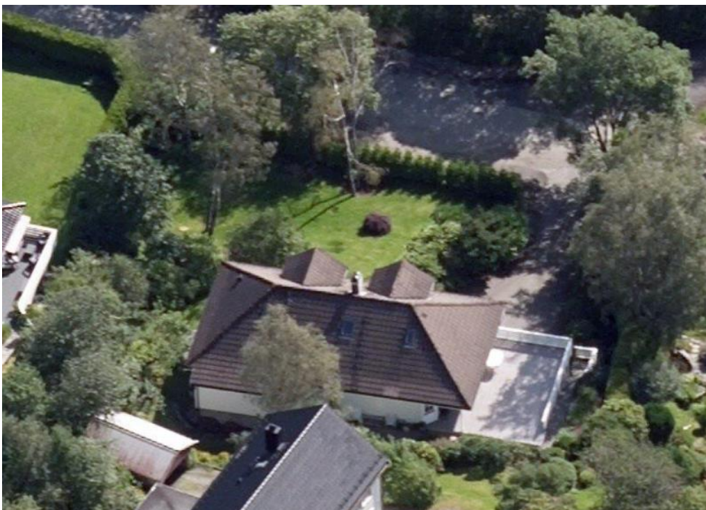
Figur 1-10 Skråfoto av fasade vest. Kilde: 1881.no.
