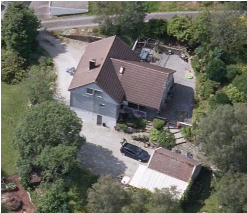
Figur 2-13 Skråfoto av fasade øst. Kilde: 1881.no.
