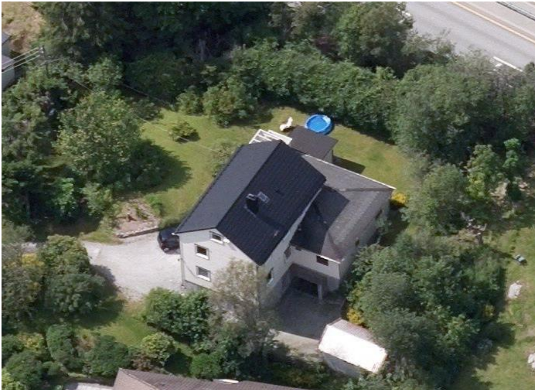
Figur 3-13 Skråfoto av fasade øst. Kilde: 1881.no.
