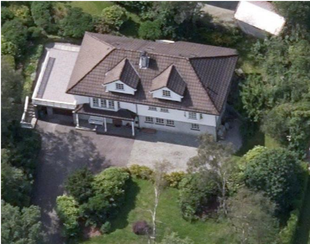
Figur 1-11 Skråfoto av fasade øst. Kilde: 1881.no.
