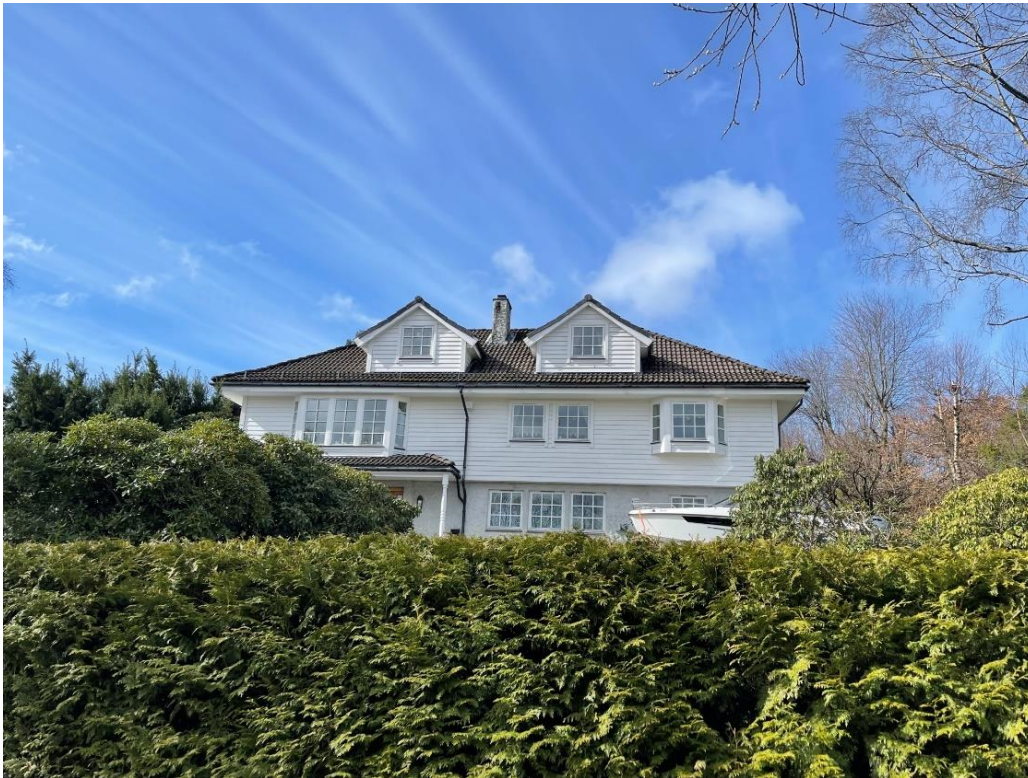
Figur 1-13 Fotografi av fasade øst. Foto: Norconsult.
