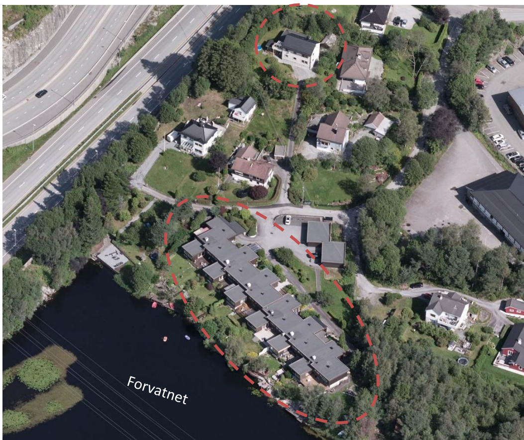
Figur 3-7 Atriumhus ved Forvasshaugen fra 1970 i front, og Forvasshaugen 15 i bakkant (begge markert med røde, stiplede, sirkler). Kilde: 1881.no, skråfoto (hentet i 2022).
