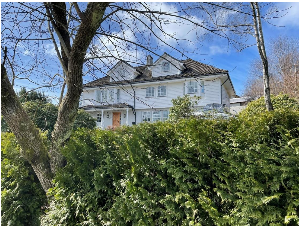
Figur 1-14 Fotografi av fasade øst. Foto: Norconsult.
