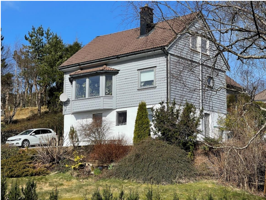
Figur 2-15 Fotografi av fasade syd, tatt fra veien Forvasshaugen. Foto: Norconsult.
