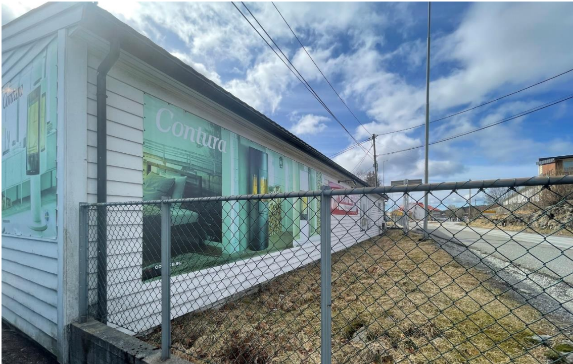
Figur 6-13: Fasade nord. Foto: Norconsult.
