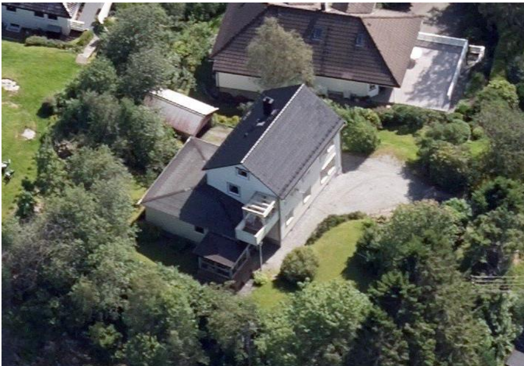
Figur 3-12 Skråfoto av fasade vest. Kilde: 1881.no.
