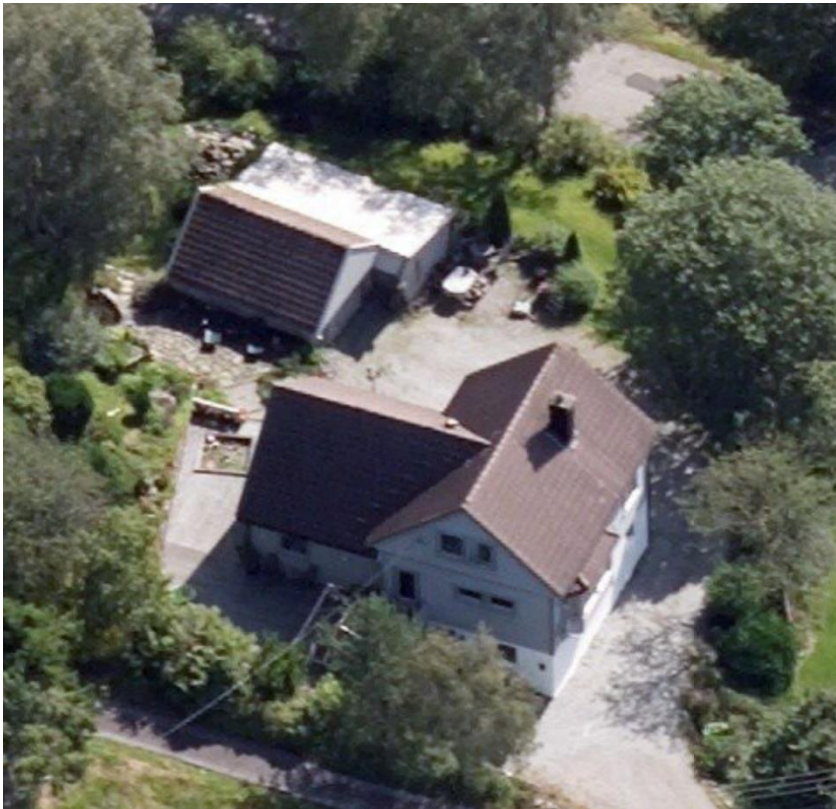
Figur 2-11 Skråfoto av fasade vest. Kilde: 1881.no.
