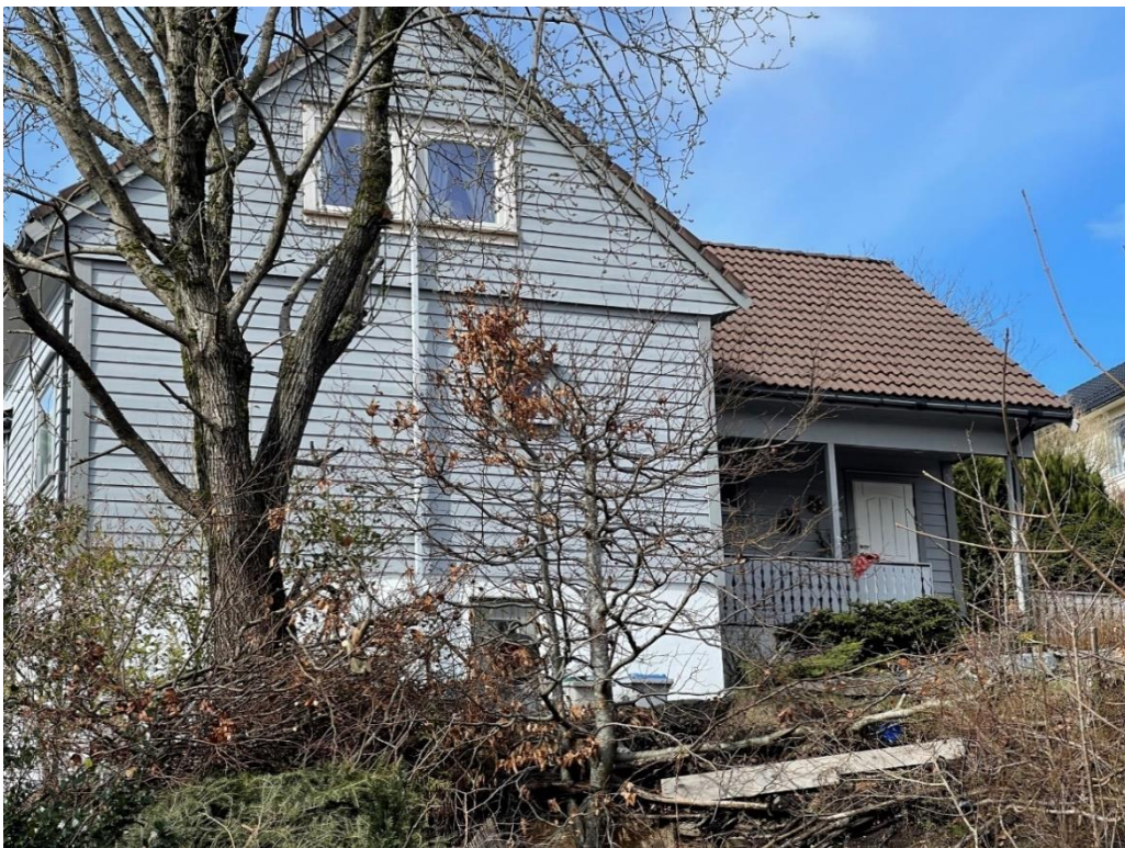
Figur 2-16 Fotografi av fasade øst, tatt fra veien Forvasshaugen. Foto: Norconsult.
